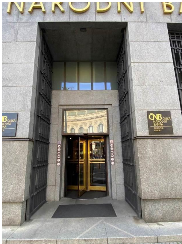
Stávající úprava karuselových dveří včetně bezpečnostního posuvného uzávěru.
