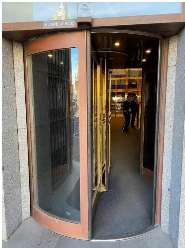
Stávající úprava karuselových dveří včetně bezpečnostního posuvného uzávěru.
