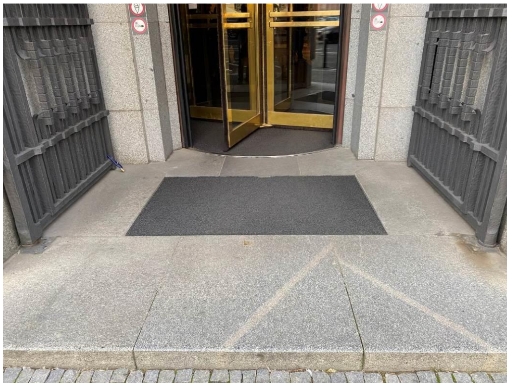
Vstupní žulový stupeň určený k úpravě na rampu
